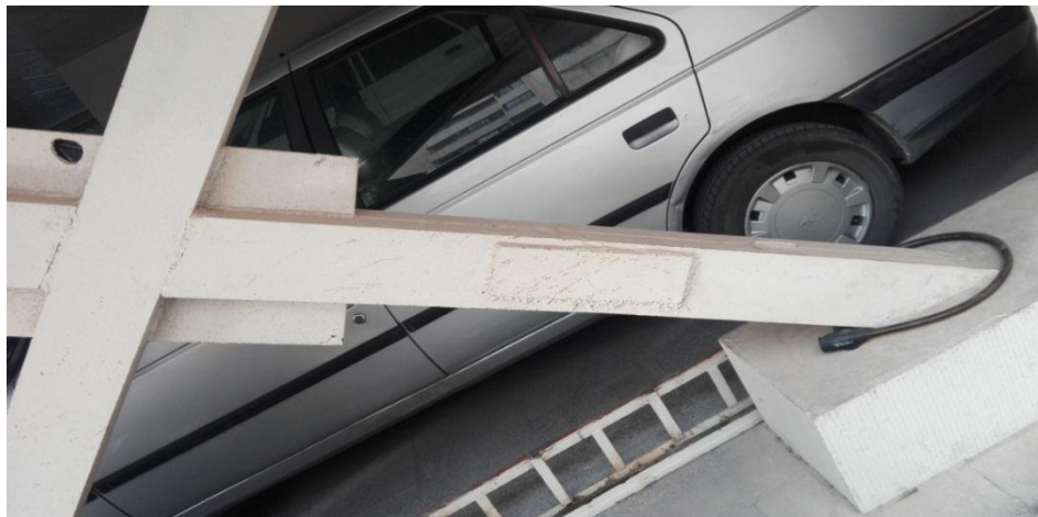
شکل ۹: وصله کردن یکی از مهاربندهای کششی.
