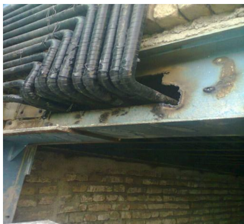
شکل ۴: سوراخ کردن کف‌های بتنی و جان تیر ورق برای عبور لوله‌های تاسیساتی.
