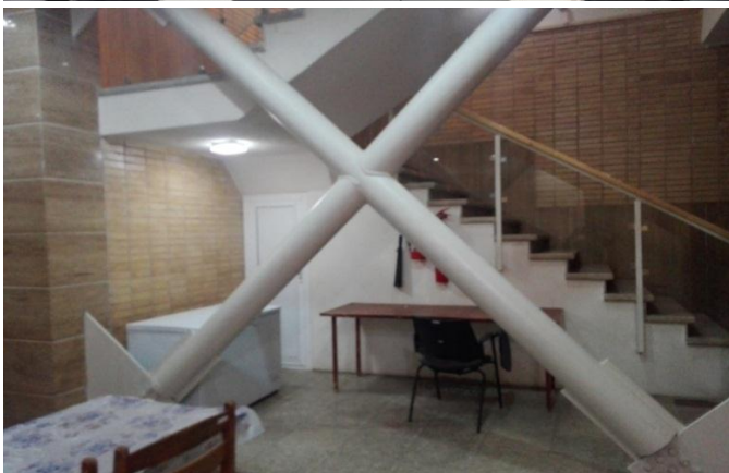
شکل ۱: در دسترس بودن مهاربندها برای کاربران که ممکن است جهت کاربری بهتر، اقدام به برداشتن آنها کنند.
