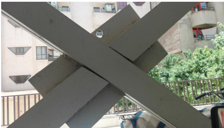
شکل ۵: سوراخ کردن قسمتی از ورق گاست برای حمل با جرثقیل.
