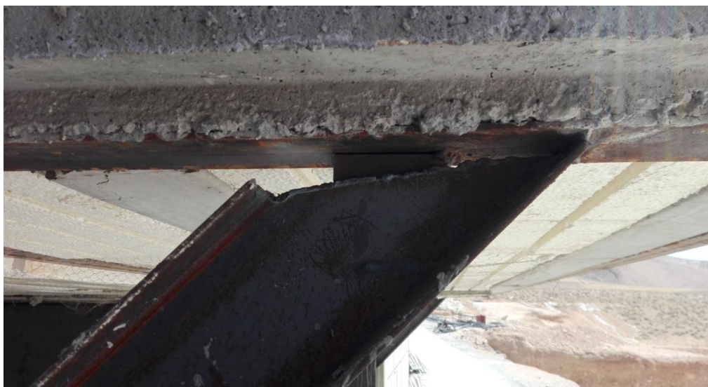
شکل ۸: کوتاه بودن دستک و عدم عملکرد مناسب این عضو در زمان اعمال بار به عضو.
