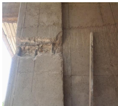
شکل ۱۰: تخریب قسمتهای اصلی ستون بتنی جهت دستیابی به میلگردها و جوش دادن قطعات الحاقی به آنها.
