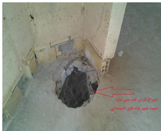
شکل ۴: سوراخ کردن کف‌های بتنی و جان تیر ورق برای عبور لوله‌های تاسیساتی.
