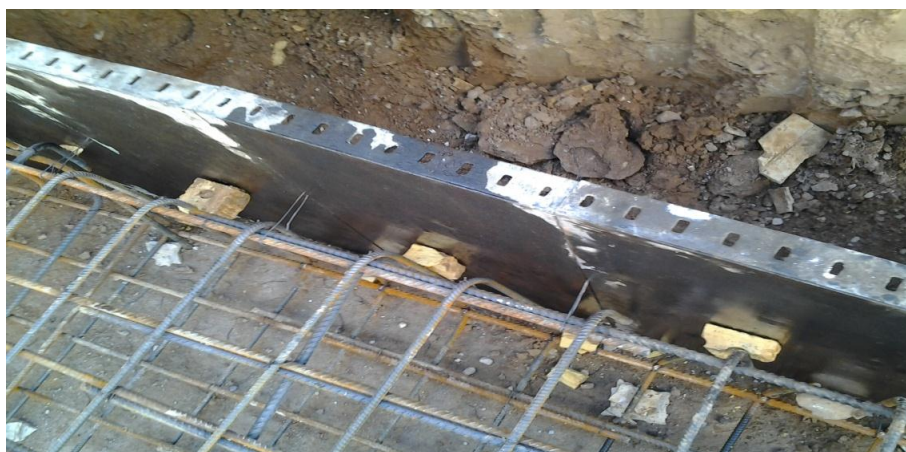
شکل ۱۲: استفاده از نخاله و خرده آجر به عنوان فاصله نگه دار در کنار قالب ها در زمان بتن ریزی.
