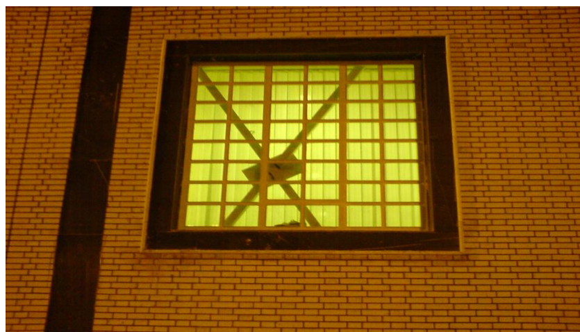
شکل ۳: عدم وجود دهانه مناسب برای مهاربند ، باعث قرار گیری آن در پنجره شده است.
