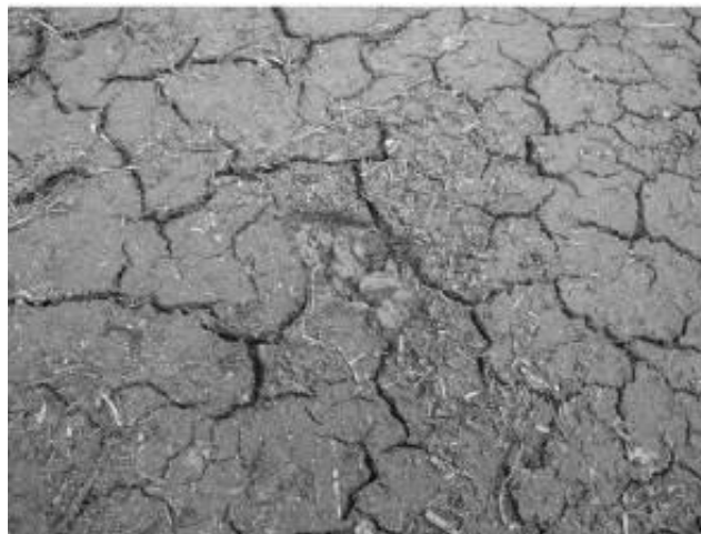
شکل ۱: ایجاد رسوب شدید در بتن متخلخل [۲].
