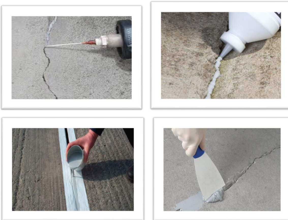
شکل ۳: پر کردن مستقیم دهانه شکاف با مواد ترمیمی و اپوکسی.
