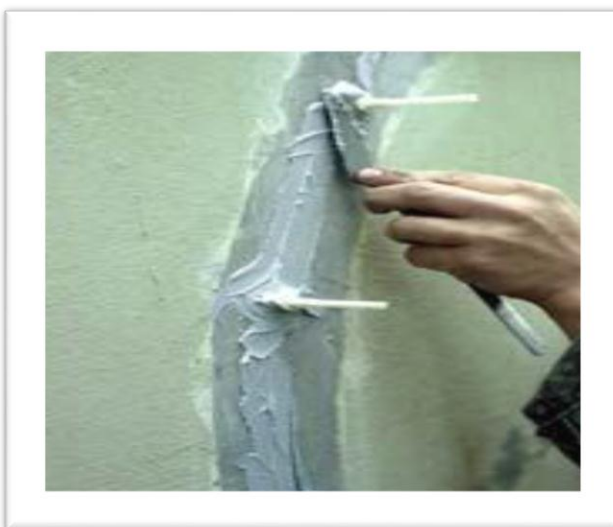
شکل ۵: ایجاد لایه درپوش برای جلوگیری از خروج مواد تزریقی.
