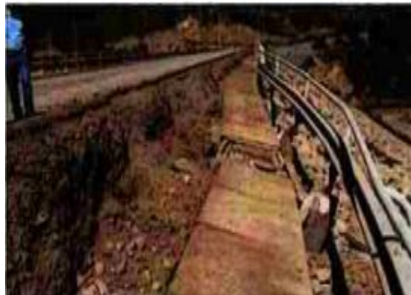
شکل ۱۶: کانال الکتریکی در شیب پایین دست در تاج سد کولبون [۲۲].
