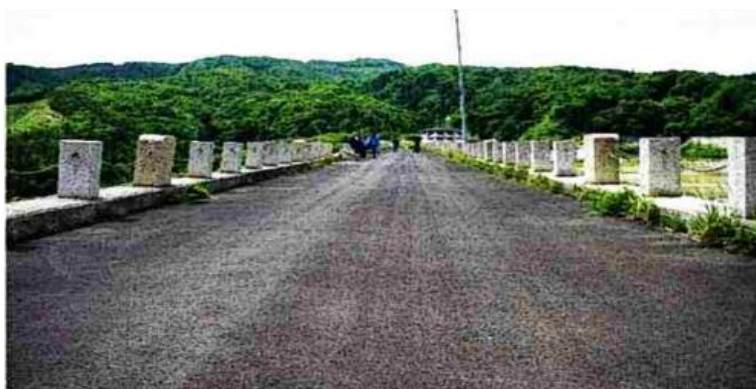
شکل ۲: نمایش تاج سد اراتوزاوا و شکست و انحراف ها آثار تاریخی (یاماگوچی و همکاران , 2008) [۱۹].
