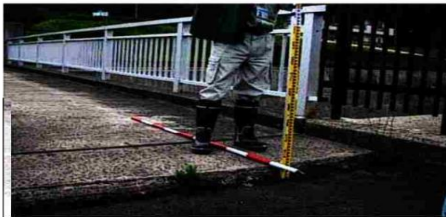
شکل ۳: ۱۰ سانتی متر نشست خاکریز در سرریز سد اراتوزاوا (تانی و همکاران، ۲۰۰۸).
