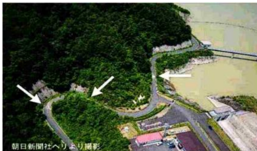
شکل ۶: عکس هوایی سه حوزه ترک خوردگی در جاده را نشان می دهد. ترک خوردگی دیوار سرریز که در شکل ۵ نشان داده شده است در زیر فلش سمت راست رخ داده است. (کایان و همکاران ، ۲۰۰۸) [۱۸].
