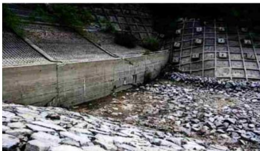
شکل ۵: ترک های دیوار حائل سرریز سد اراتوزاوا (کایان و همکارانش در سال ۲۰۰۸) [۱۸].
