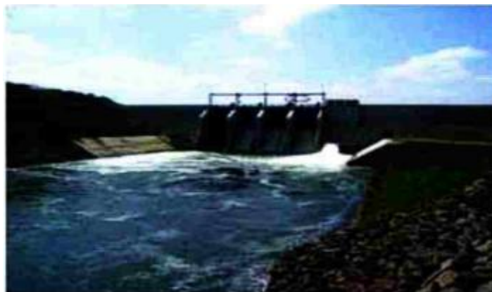
شکل ۱۸: سرریز در پایین دست سد کونونتو ویجو [۴۳].
