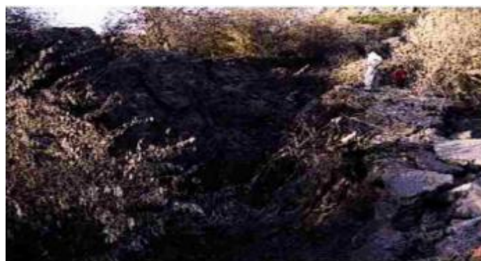
شکل ۱۰: یک ترک طولی بزرگ، تقریباً ۱۰ متری که در نزدیکی تاج سد چانگ دیده شده است. (پاتل و براهمایهات , ۲۰۰۳) [۴۰].
