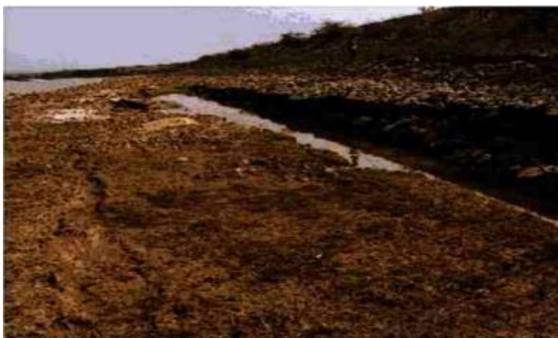
شکل ۱۳: رانش جانبی در نزدیکی پنجه سد تاپار (براهمایهات و جوداو، ۲۰۰۳) [۴۰].
