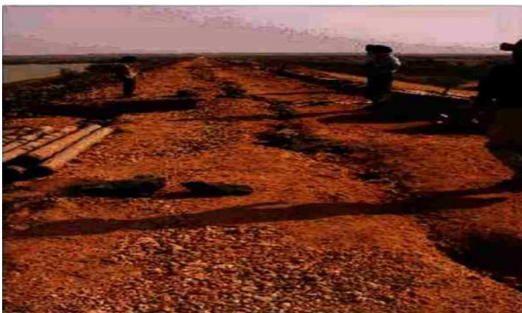
شکل ۱۴: ترکهای طولی در امتداد تاج سد تاپار به عمق ۳ متر [۳۷] و
