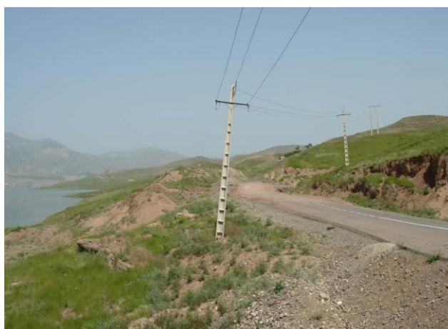
شکل ۶: کج شدن تیر برق [۱۷].
