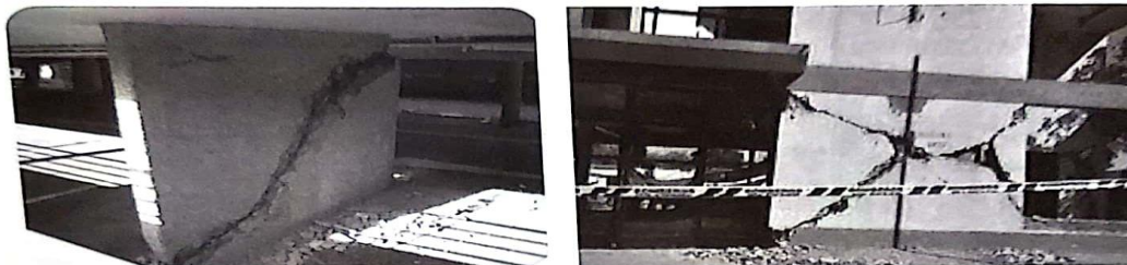
شکل ۵: انهدام برشی دیوارهای برشی (خیرالدین، امامی ۱۳۹۸).
