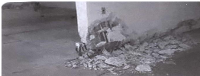
شکل ۷. انهدام لغزشی دیوار برشی (خیرالدین، امامی ۱۳۹۸).
