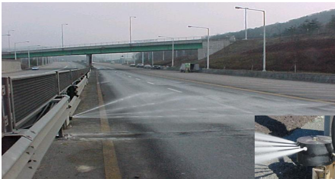
شکل ۱: روش مکانیزه پخش مواد ضد یخ در سطح روسازی [۲]
