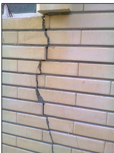
شکل ۴: نمونه ای از بروز نشست سازه ها کوی باغمیشه
