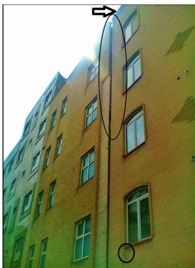
شکل ۴: نمونه ای از بروز نشست سازه ها کوی باغمیشه
