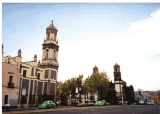
شکل ۷: فرو رفتن سازه های تاریخی شهر مکزیکوسیتی در اثر نشست لایه های رسی اشباع [۹]
