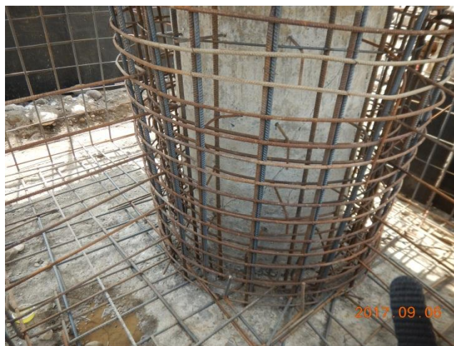
شکل ۲۴: آرماتوربندی ژاکت بتنی پایه پل مدل آزمایشگاهی.
