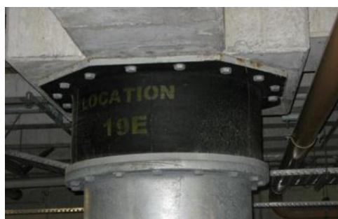
شکل ۱: نمونه‌ای از جداساز لاستیکی با میرایی بالا [۳].
