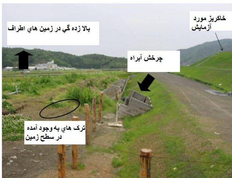
شکل ۳: تغییرات سطح زمین در اثر احداث خاکریز [۱۴].
