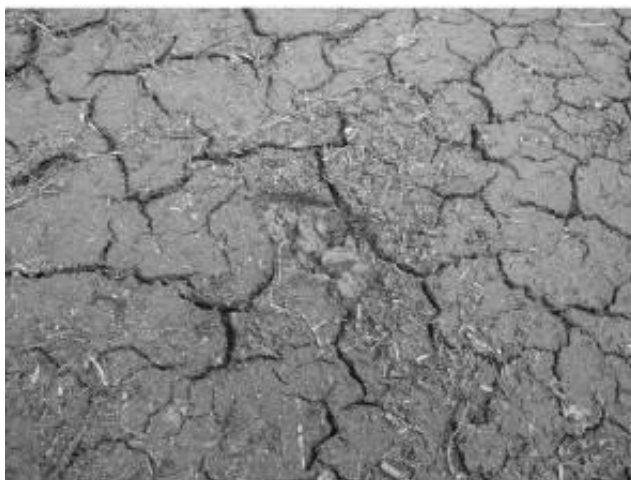
شکل ۱: ایجاد رسوب شدید در بتن متخلخل [۲].
